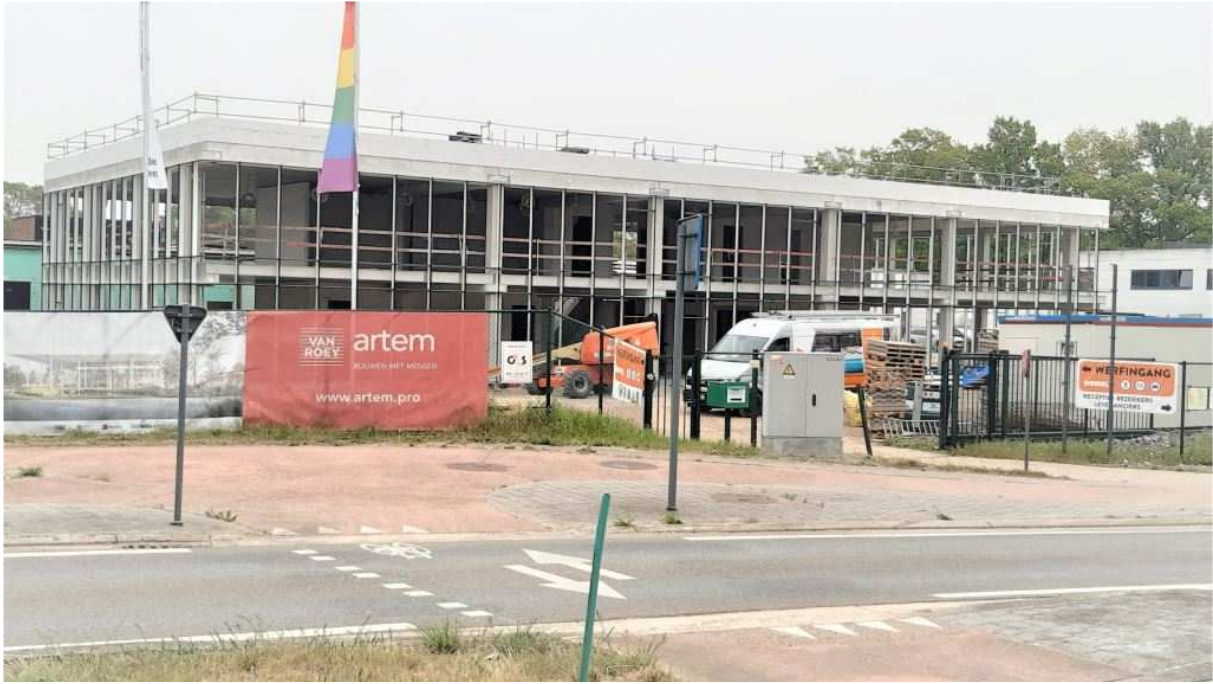
21: kantoorgebouw Bewel - ruwbouw
