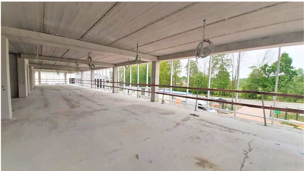
22: kantoorgebouw Bewel - ruwbouw
