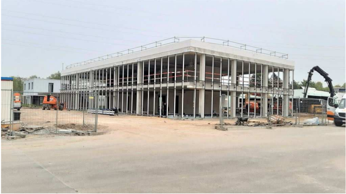
23: kantoorgebouw Bewel – ruwbouw
