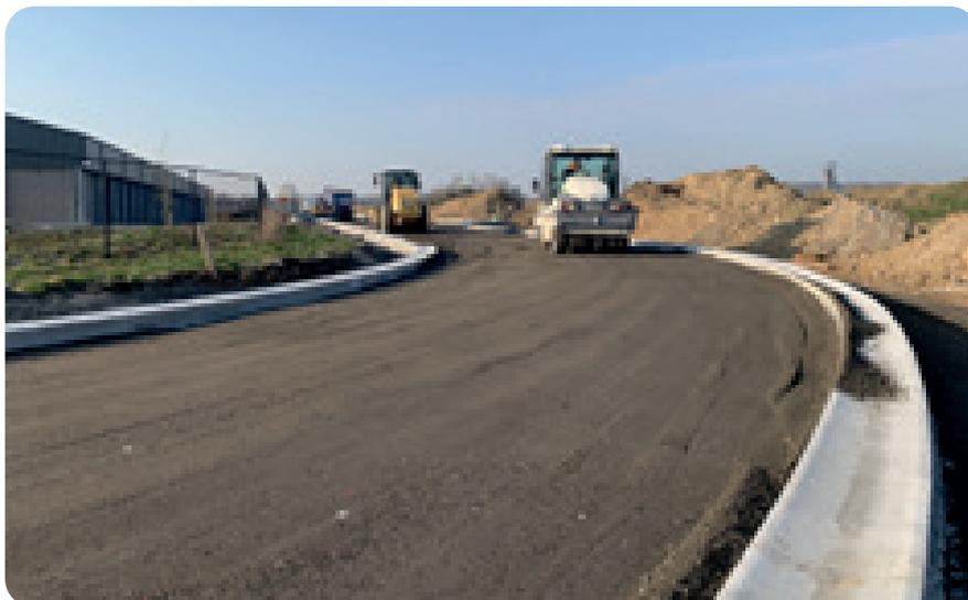
Mise en œuvre d'une fondation en béton maigre recyclé
