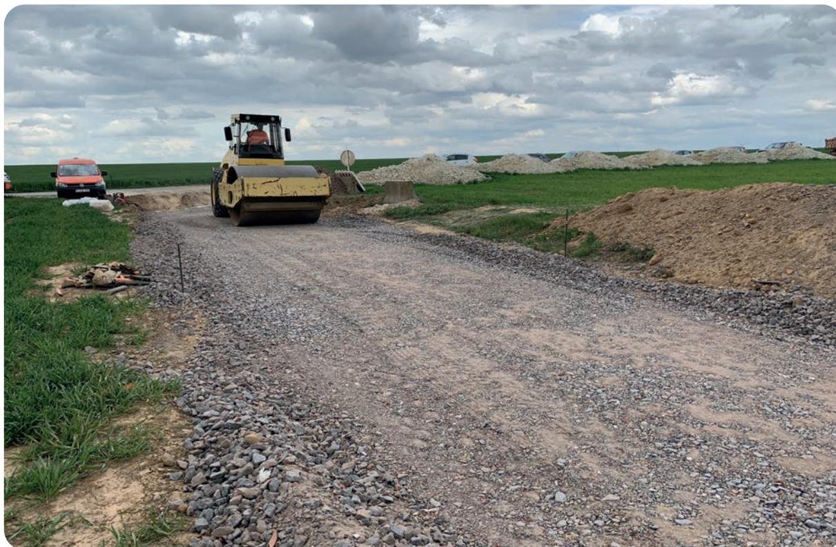
Mise en œuvre d'une fondation drainante en granulats recyclés (projet RIDIAS)
