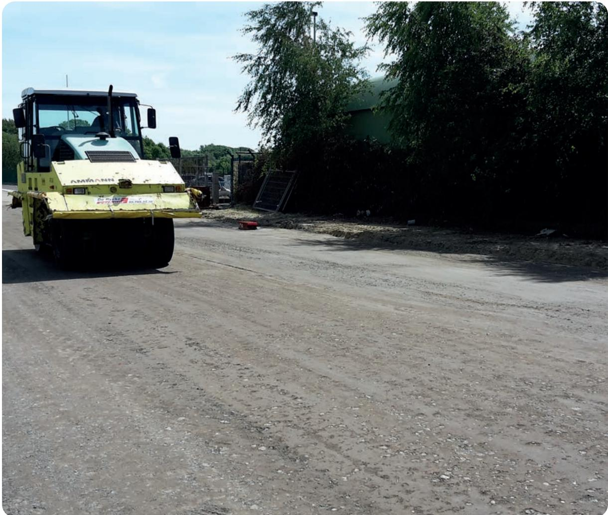
Mise en œuvre d'une fondation en béton maigre recyclé
